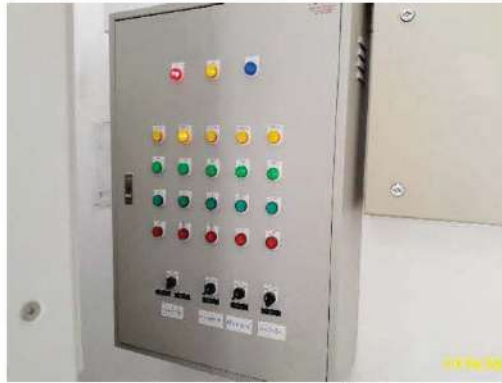
ตู้ควบคุมระบบบำบัดน้ำเสีย ภาพที่ 1.3.5-1 (ต่อ) การบำบัดน้ำเสีย
