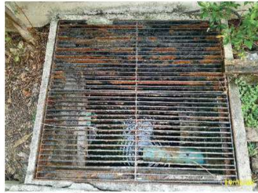
บ่อพักน้ำก่อนระบายออกสู่สาธารณะ
